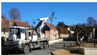
La dépose d'un ancien poteau
